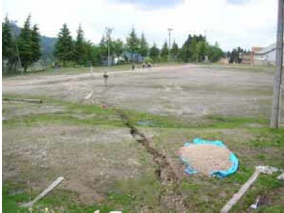
写真-12 山古志中学校グラウンドの亀裂 (平成 17 年 5 月 23 日撮影)
