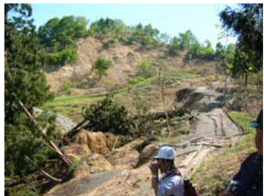
写真-2 入道沢地すべり上部ブロックの全景
