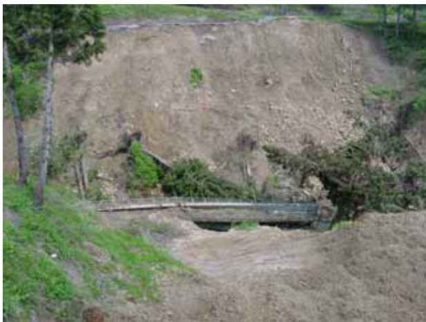
写真-9 末端部では橋が落下している
