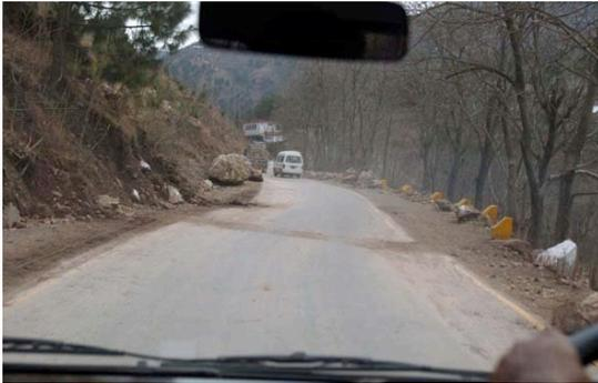
写真4 震源断層近隣の道路面の変状
