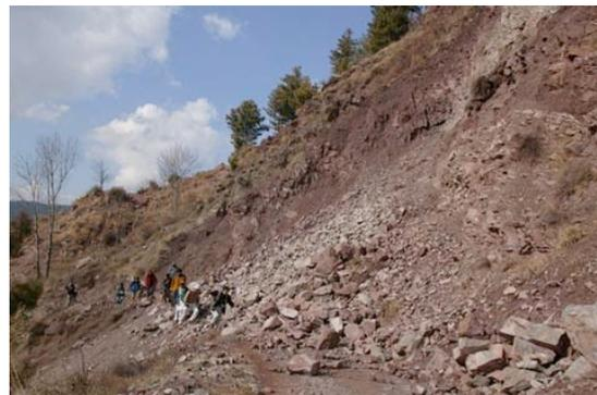
写真8 ハッティアン村に向かう林道の崩壊
