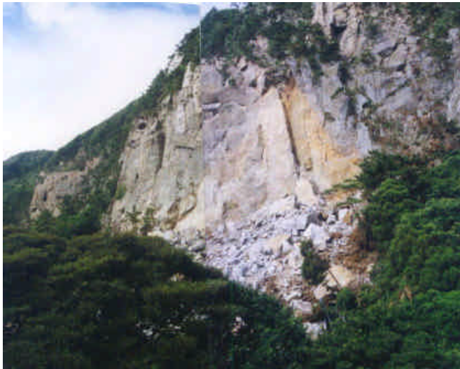
写真-3 柱状節理の発達する流紋岩体の急崖の崩落（若郷集落北端の新島山西斜面）。
