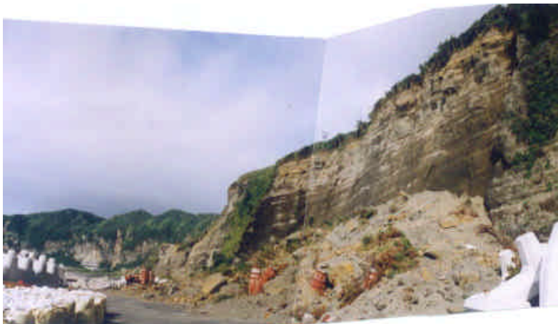
写真-8 ベースサージ堆積物からなる崖の崩壊（井沢磯） 比高約60m、勾配約70°の急崖全体の約80%が崩壊した。崩積土塊の表層には
