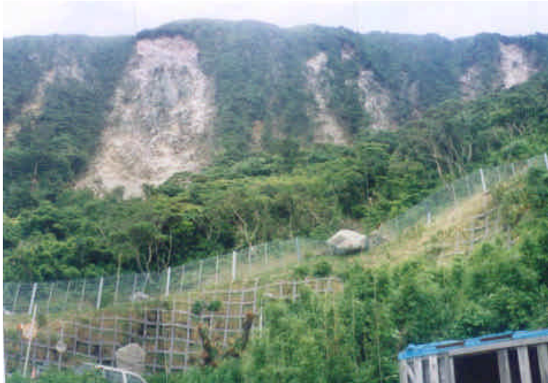
写真-7 上部の火砕岩部分の崩壊状況（新島山西斜面） 流動した土砂は流理や節理のある流紋岩を岩塊として取り込んだ。（写真-5の北に隣接する箇所）
