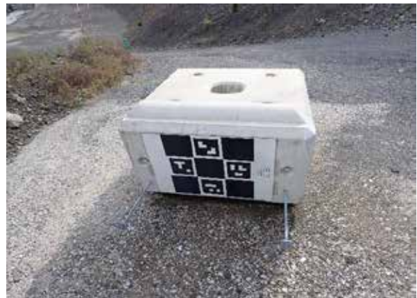
写真-3 自動化施工に用いたコンクリートブロック
