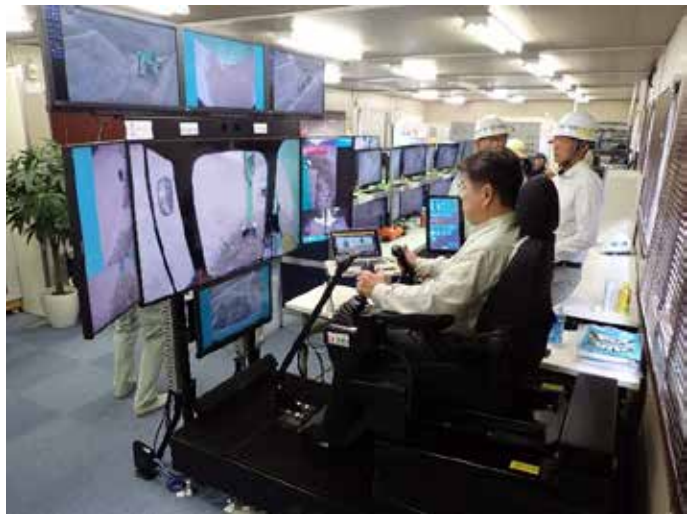
写真-2 無人化施工機械の操作の様子
