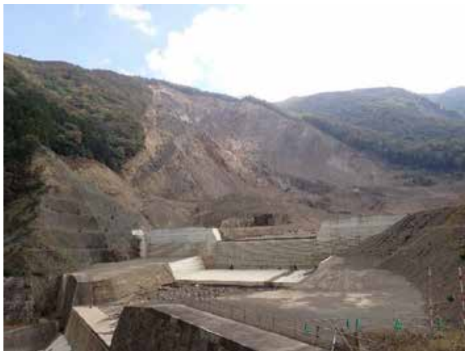
写真-1 赤谷地区見学箇所から崩壊箇所を望む （手前は2号・3号砂防堰堤）
