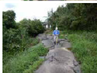
③ 下部市道の押し出し
