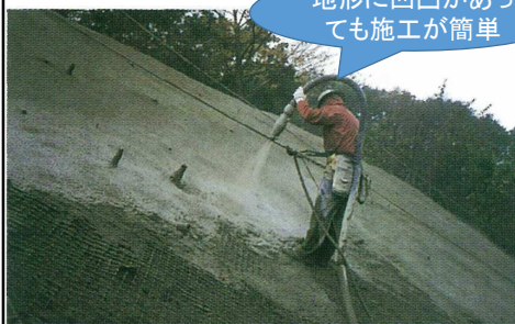
モルタル吹付施工状況 (高速道路技術センター: 現場のチェックポイント, 平成11年3月より引用)
