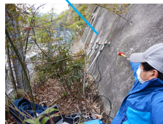
一次元表面波探査実施状況
