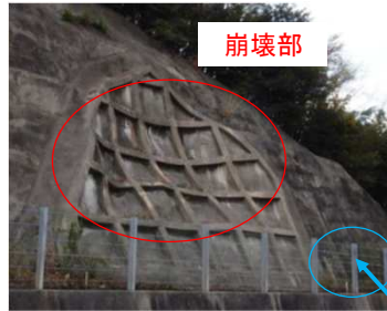
現在のモルタル吹付斜面の状況
