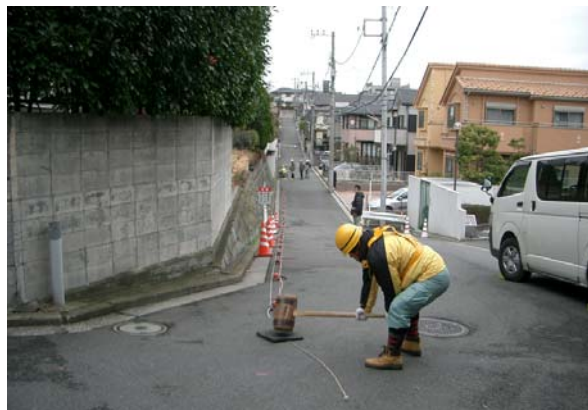
図 15 表面波探査作業風景 (ガイドラインより)
