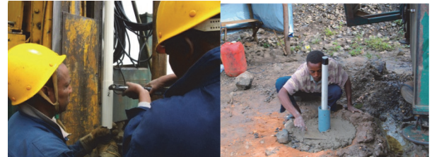
写真-5 孔内傾斜計ガイドパイプ設置指導
