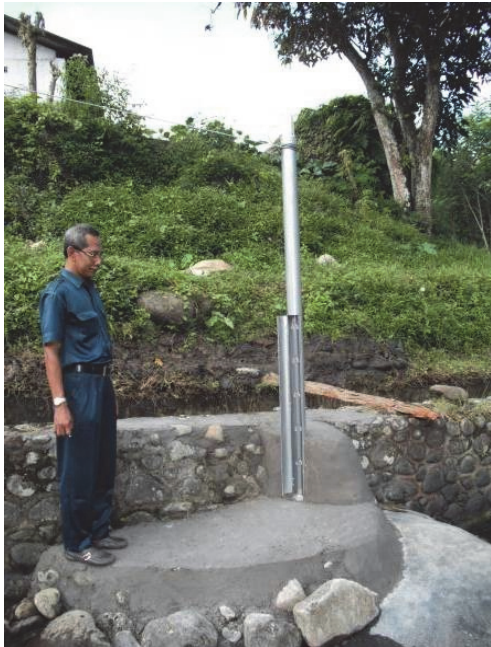
写真-3 ジョンポ川に設置した水位計
