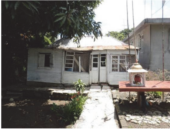
図-13 家屋の変形（チトラクト）
