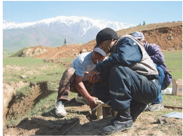
図-18 埋設型の伸縮計設置状況
