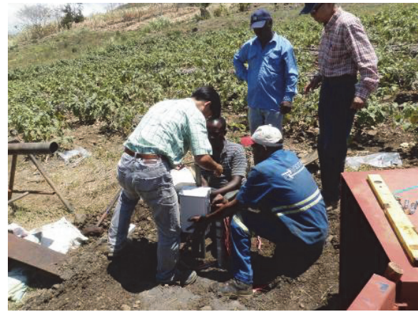
図-22 パイプ歪計の設置状況
