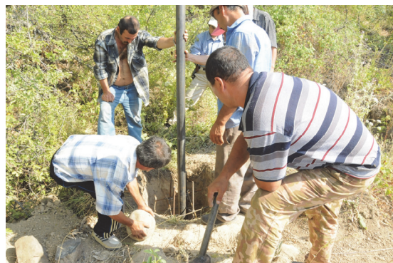
図2 長スパン伸縮計用の支柱の設置作業。現地技師の経験を活かした固定方法を採用することは多い。
