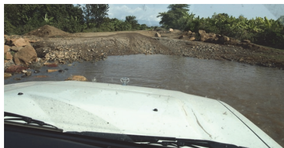
写真-2 河川により寸断された国道 9 号線の様子
