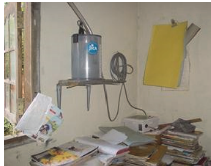
写真-7 室内に設置されたセンサー
