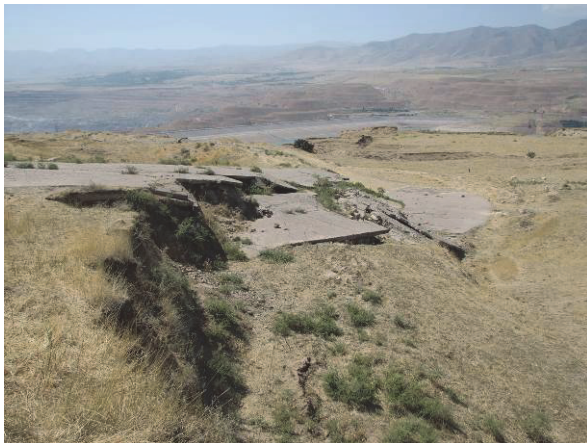
図-8 破壊された道路（テクスティルシク）
