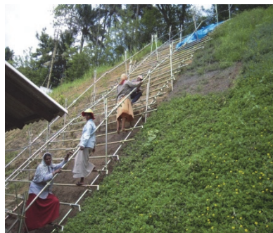
写真-13 斜面保護工（植生工）
