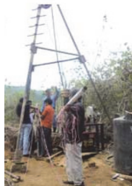
写真-14 伸縮計の設置
