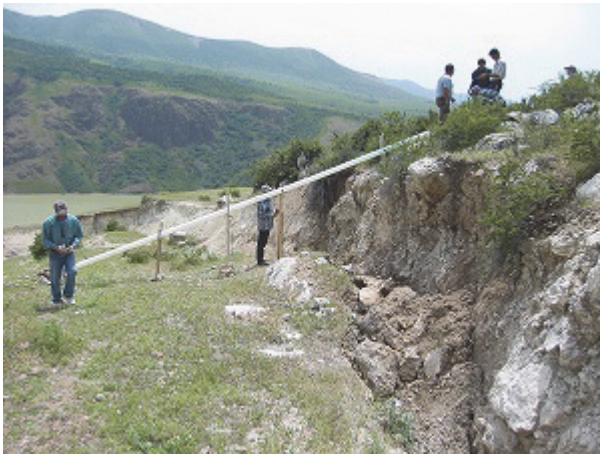
図-17 滑落崖に伸縮計設置状況
