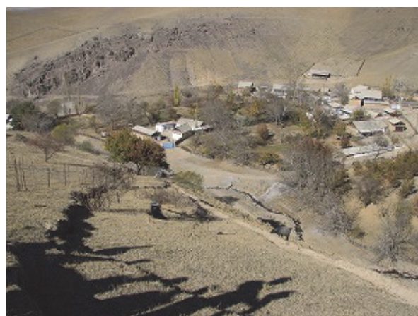
図－４ ベドレンゲット地すべり全景
