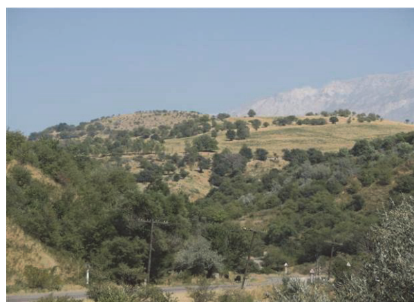
図－５ ウチテレック地すべり全景
