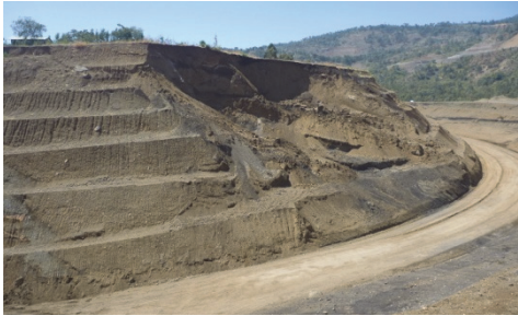
写真-3 道路開削工事に伴う地すべりの例
