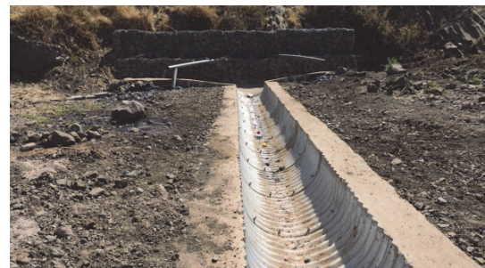
写真-11 C/Pの指導により一部完成した横ボーリング工(奥)とその流末処理の明暗渠工
