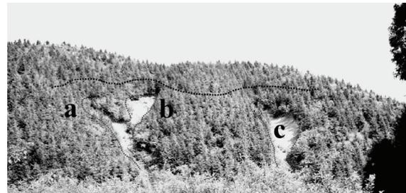
写真-12 自然斜面 C で発生した表層崩壊
