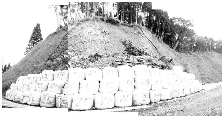
写真-16 林道 C で発生した法面崩壊
