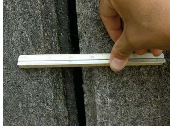
写真-4 住宅基礎擁壁に生じた亀裂変状
