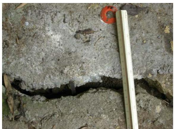
写真-5 住宅基礎コンクリートたたきに生じた亀裂変状
