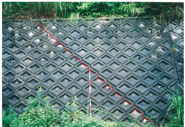
写真-3 林道三国越線沿いのブロック積み擁壁の変状
