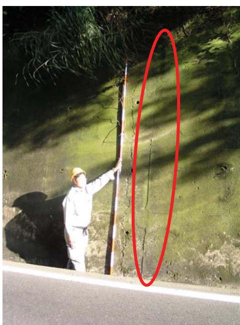
写真-13 国道 163 号沿いのコンクリート擁壁に認められる亀裂
