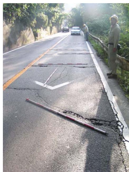
写真-14 国道 163 号に発生した横断亀裂
