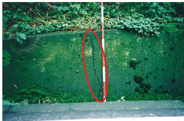
写真-12 国道 163 号沿いのコンクリート擁壁に認められる亀裂
