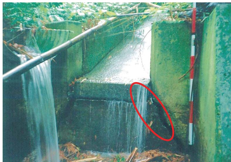
写真-10 水路工の亀裂 (亀裂幅  $W=30\text{mm}$ )
