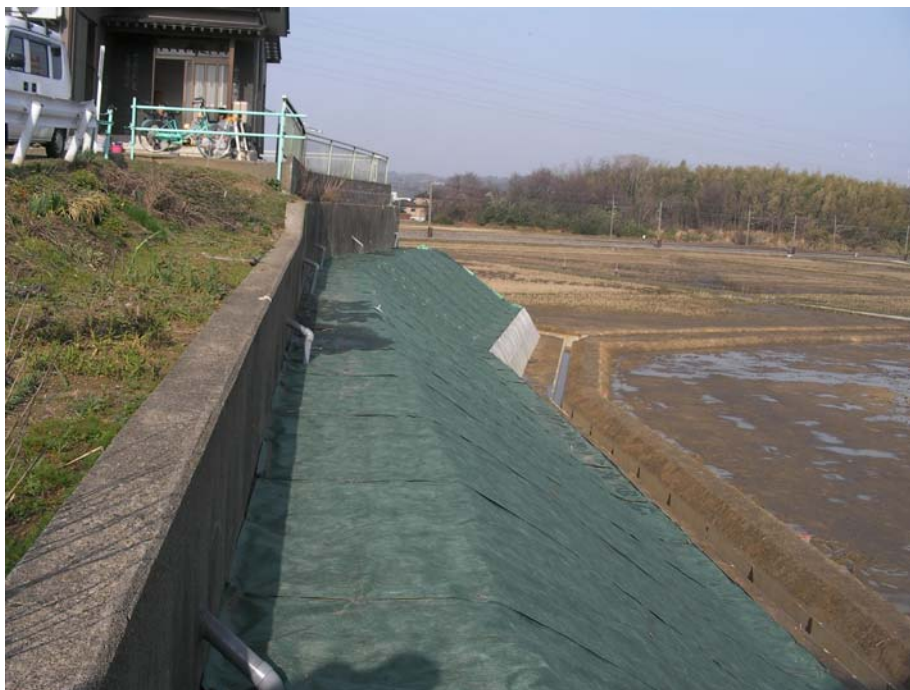
図 - 2 6 柏崎市が施工した不安定擁壁の押さえ盛土．
