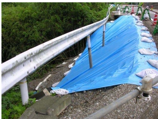
図 - 1 4 番神地区の道路法面崩壊 (図 13 中の P1)
