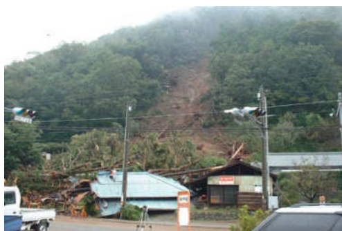
平成16年災害発生時
