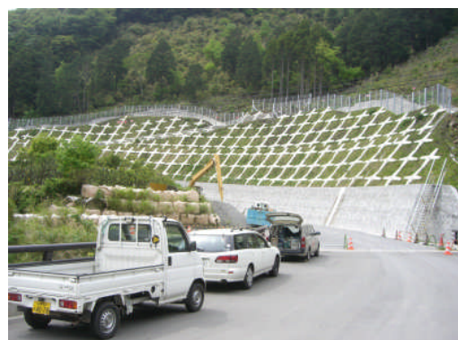
法面に施工されたアンカー工
