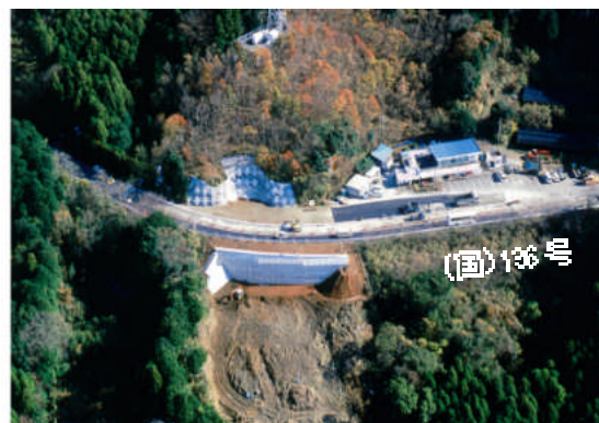
平成20年12月(復旧後)
